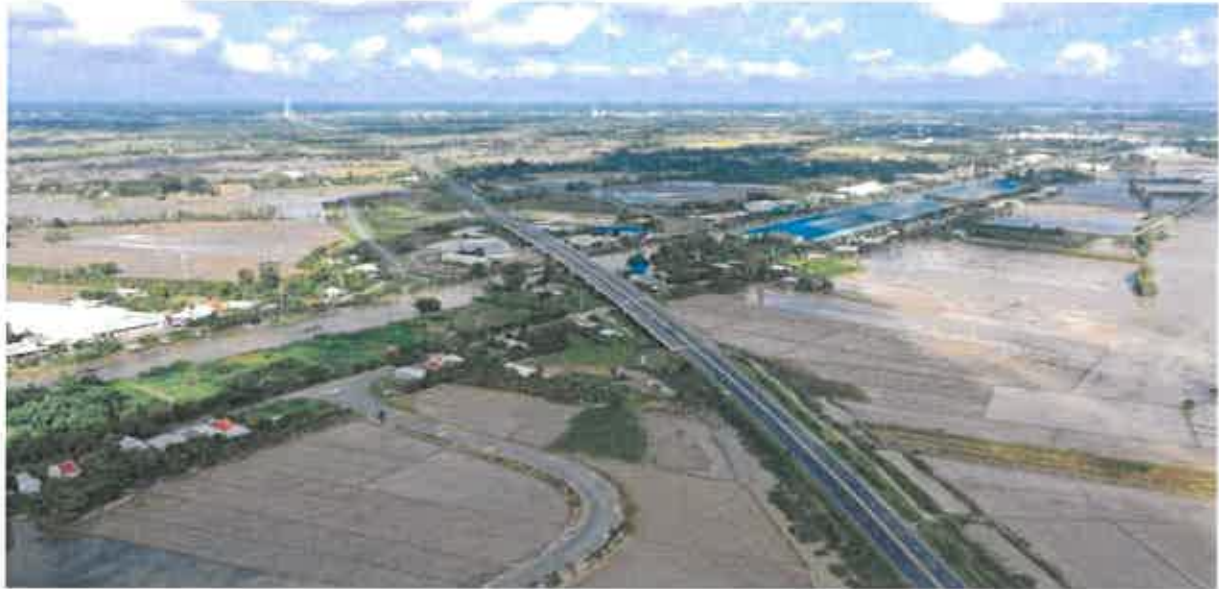
(Hình ảnh dự án Tuyến đường Cao Lãnh – Vàm Cống)
