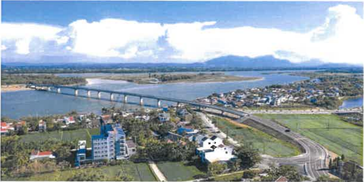
(Hình ảnh dự án đầu tư xây dựng cầu Cẩm Kim-QL.14H, tỉnh Quảng Nam)
